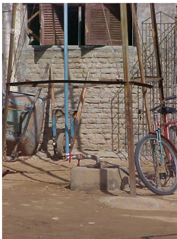
Foto 5.1.4 – Localização Inadequada do Poço (Próximo a residência e sem proteção)
