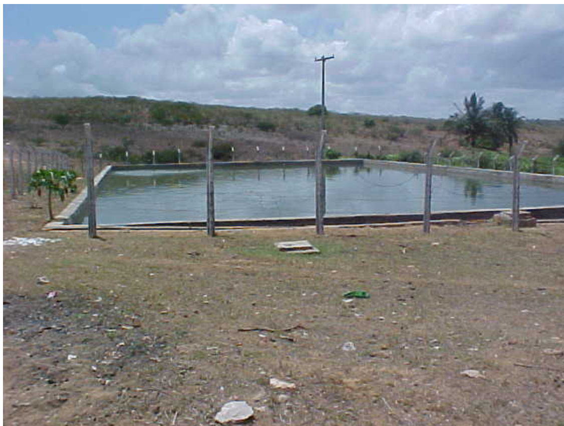
Foto 5.1.13 – Vista Geral da ETE 1 – Lagoa Anaeróbia dentro da Área Urbana
