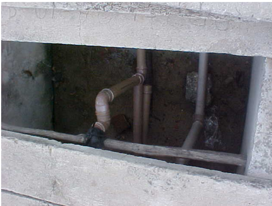
Foto 5.1.30 – Derivação para Atender Chafariz com Instalação Provisória e Inadequada (sem blocos de ancoragem)
