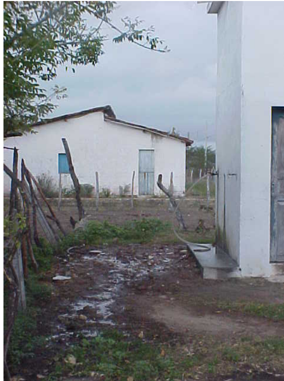
Foto 5.1.32 – Chafariz com Extravasamento Contínuo (sem bóia)
