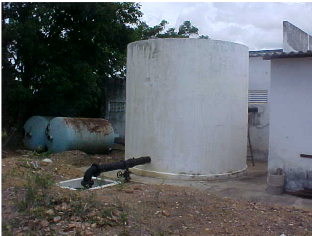
Foto 5.1.11 – Reservatório Apoiado – 100 m 3
