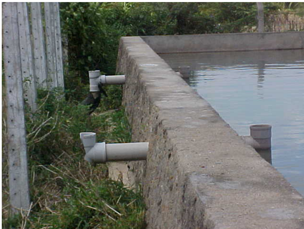
Foto 5.1.14 – Detalha da Saída da ETE 1 – Tubulação Entupida
