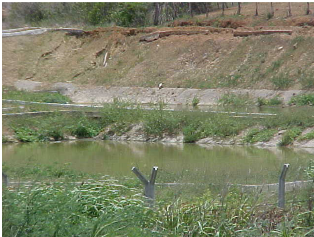
Foto 5.1.24 – Detalhe de talude da ETE - Sem Proteção e com Processos Erosivos.
